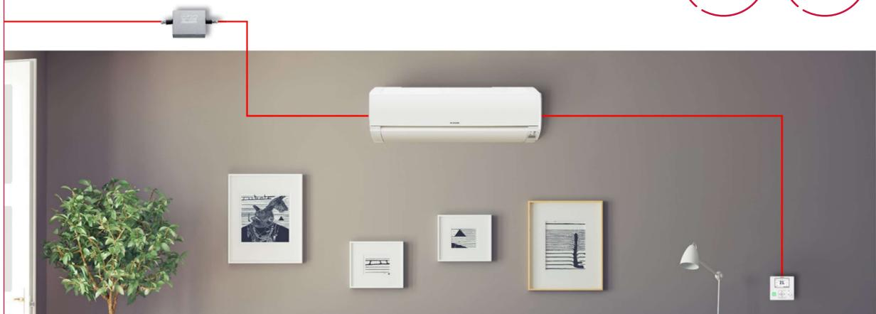
Sur les unités intérieures de type mural, le détendeur peut être placé hors de la pièce réduisant ainsi significativement le niveau sonore afin de garantir un confort acoustique optimal.
